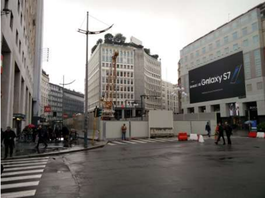
Cantiere Stazione San Babila
