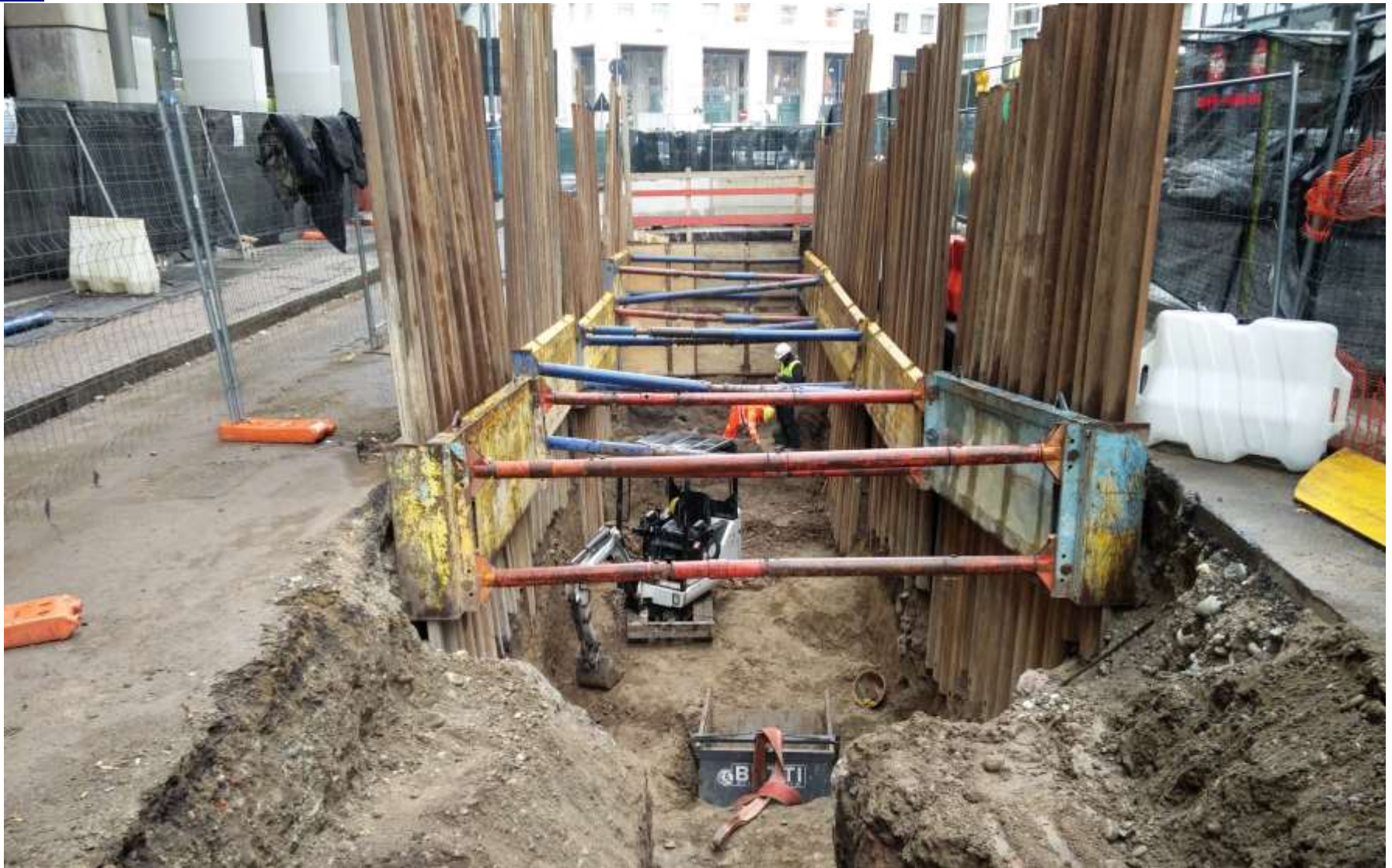
Dettaglio area di cantiere – interventi fognatura su c.so Europa
